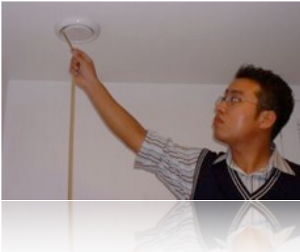
現場で換気空気量を測定するスタッフ
