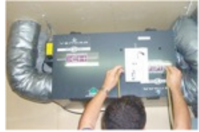
現場で換気システム風量測定をするスタッフ
