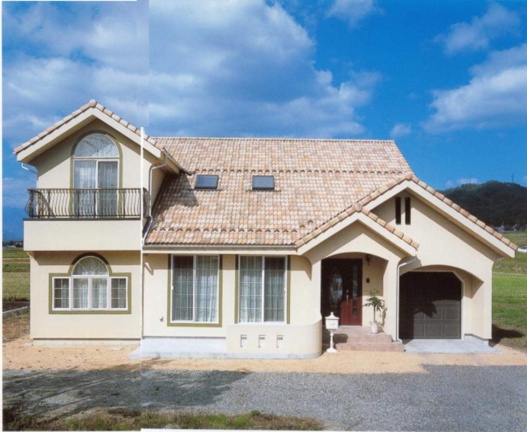
南仏プロヴァンスの家をイメージした外観正面。屋根材は凍害に耐える国産陶器瓦を使用した。
